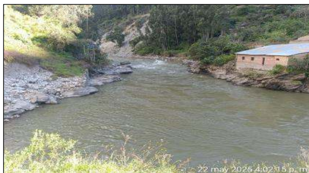
Figura 1. Muestra el desbordamiento del río Marañon en el Sector Chuquibamba 02, donde el aumento del caudal ha provocado erosión en la margen derecha. Se observa una vivienda severamente afectada por la socavación del terreno, con riesgo de colapso, y un puente que podría estar comprometido debido al deterioro estructural causado por la crecida del río.
